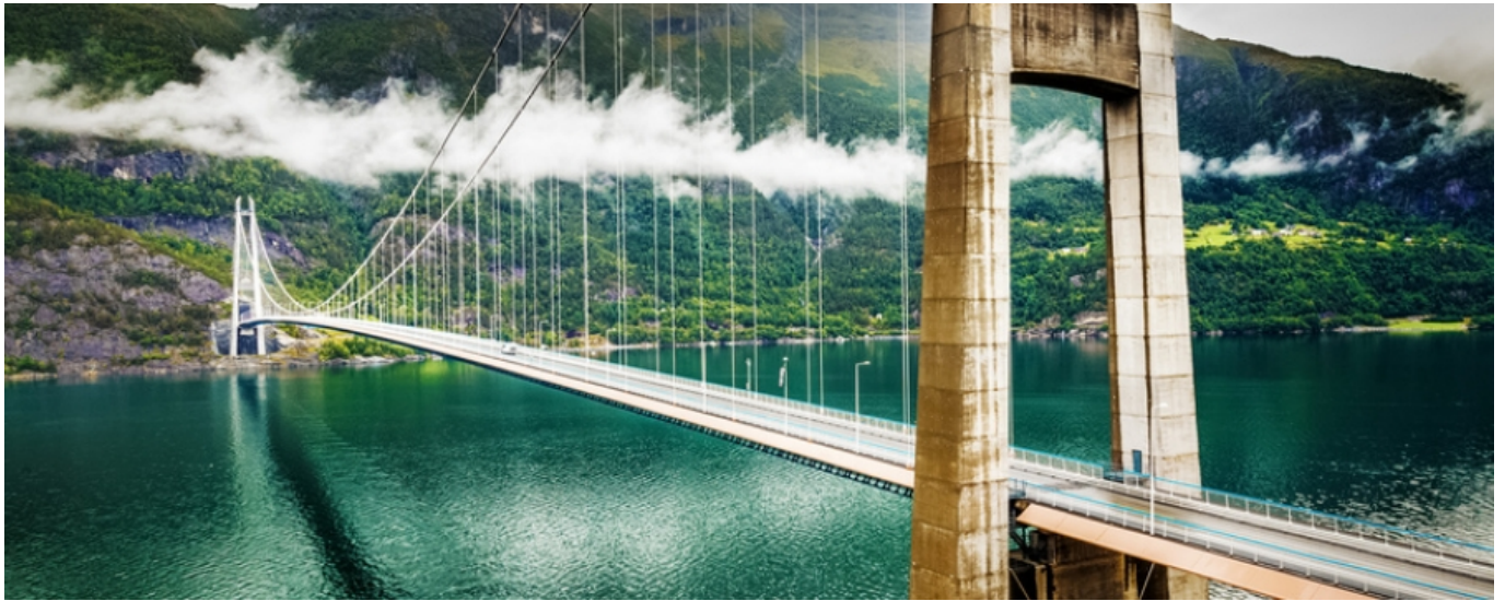
Hardanger Brücke in Norwegen
