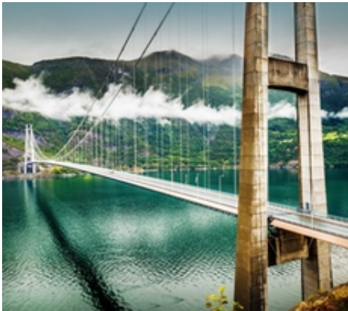
Hardanger Brücke in Norwegen
